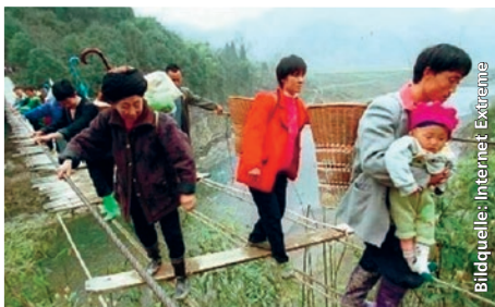
Abbildung 1: Defekte Brücke auf dem Weg zum Markt
